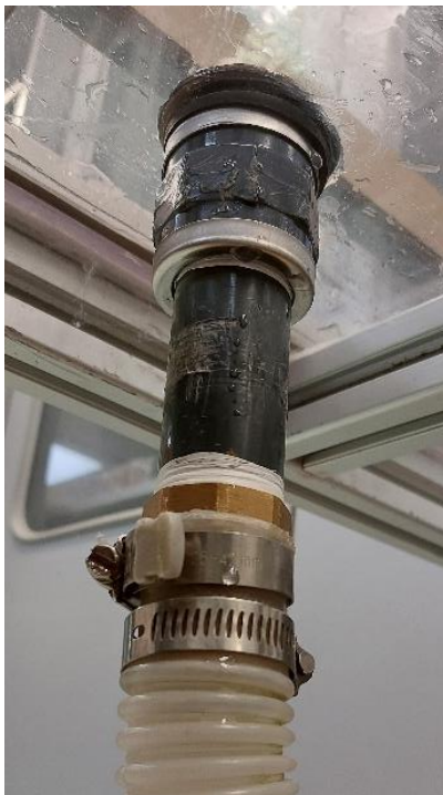
Figuur 133 Aansluiting pomp
