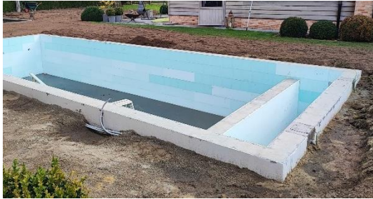
Figuur 2 Ruwbouw zwembad
